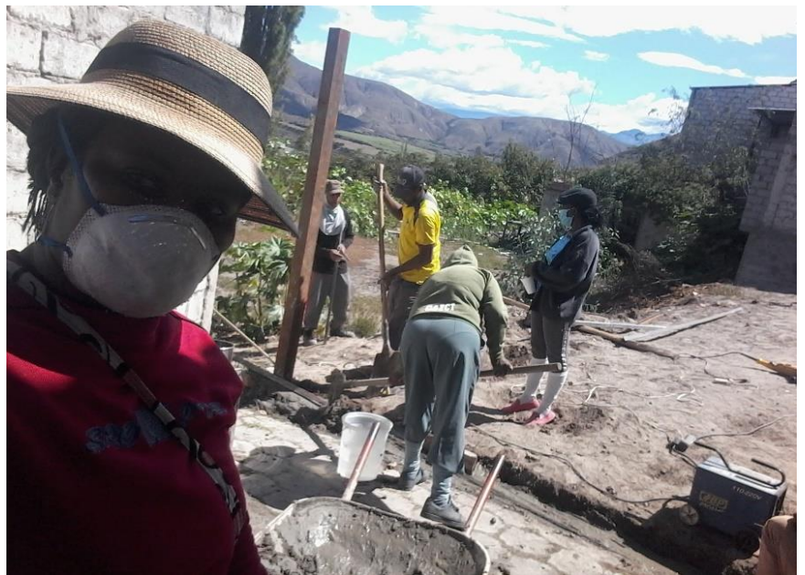
Grupo Leche de Cabra bei Bauarbeiten der Molkerei
