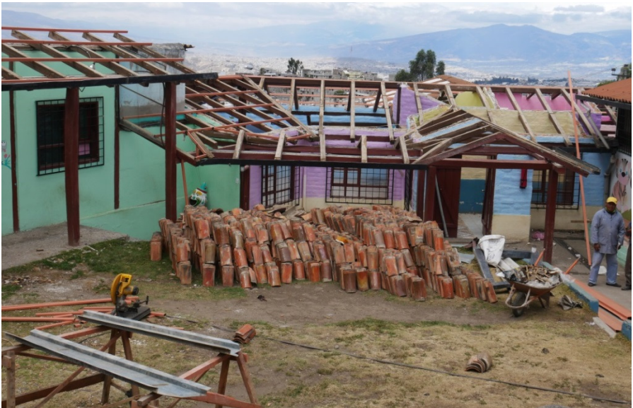
Reparatur des Daches beim Centro Miguelito im August 2019
