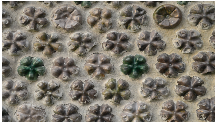
Als Basis für die Bausteine dienten mit Sand gefüllte Plastikflaschen.
